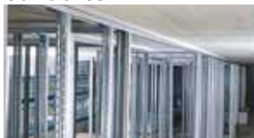
Canaletas (o canales) para fijación de paneles de yeso sobre concreto o acero
