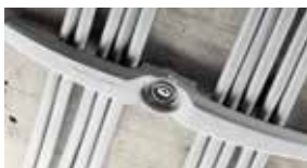
Fijación de cableado
