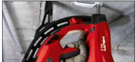
Fijación de cableado
