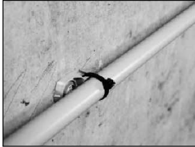
Tuberías para cables rígidos o flexibles, con sujetacables
